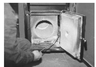
**Controlar dispositivo de seguridad de descarga térmica**
