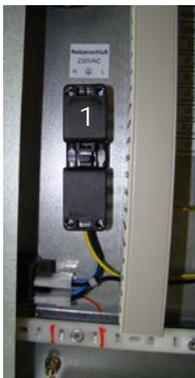
Conectar la alimentación eléctrica en el enchufe "Conexión a la red"
