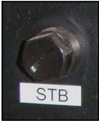
Detiene la combustión cuando la caldera alcanza una temperatura máxima de 100°C. Las bombas siguen funcionando.
