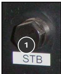
El limitador de temperatura de seguridad (STB) desconecta la caldera cuando se alcanza una temperatura de aprox. 100°C. Después de que la caldera se haya enfriado, es necesario desbloquear manualmente el limitador de temperatura de seguridad:
